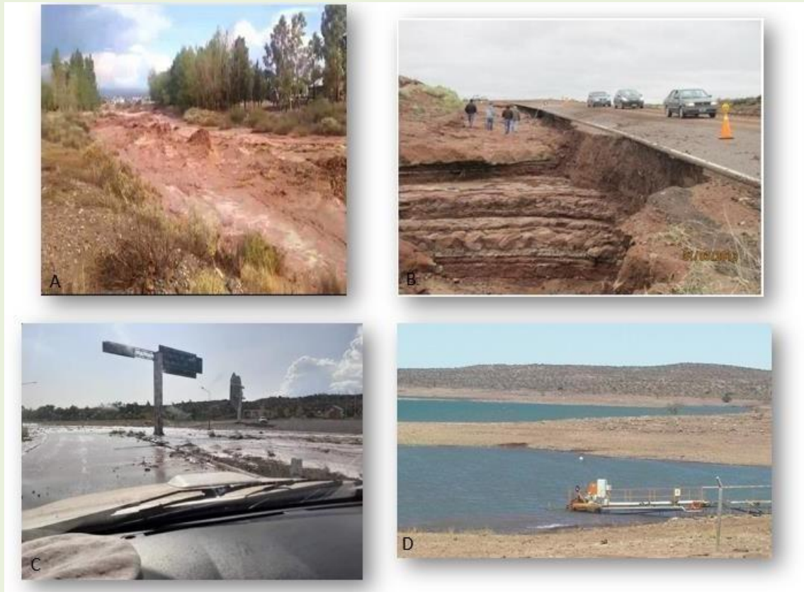
Ilustración 1. Fotografías de los impactos producidos por la amenaza de tormenta de lluvia en: a) Desborde cañadón zona urbana Barrio Llequén Puente RN 237 Km 1300 13/01/2020; b) RN 237 Km 1297 socavón en acceso a la localidad c) Acceso a Villa Km 1297 d) Sector Bombeo de agua Lago Ramos Mexía, turbidez provocada por lluvias torrenciales aporte de material de cañadones.
