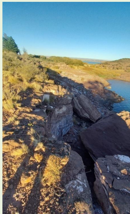
Ilustración 5. Fotografías de los impactos producidos por la amenaza de caída de rocas. Fuente: Dirección de Medio Ambiente.
